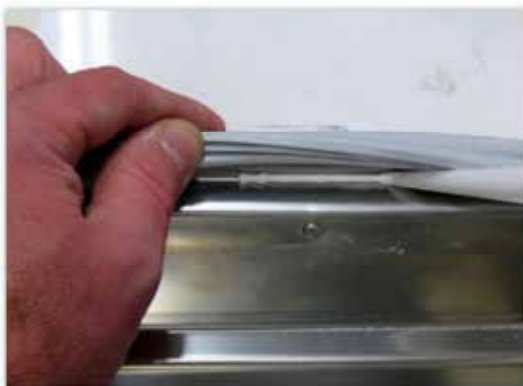
Figura 25: esempio fissaggio guarnizione ad un lato del giunto
