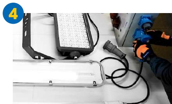
4 COLLEGA LA PRESA XCEE CHE ALIMENTA LA LINEARE BRAVO ALLA SPINA XCEE SUL QUADRO TAIS CUBE CIECO
