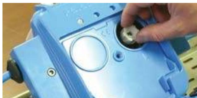
Sia nella versione in tecnopolimero che nella versione in lega di alluminio il fusibile di protezione è sempre sostituibile in condizioni di massima sicurezza, senza dover aprire la cassetta.
