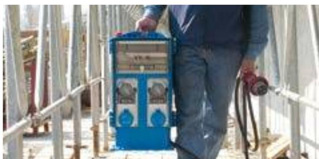
Il maniglione ergonomico consente di trasportare facilmente il quadro all'interno del cantiere.
