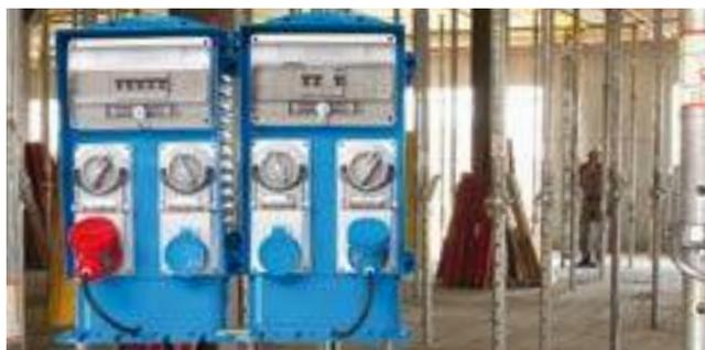
Lo sportello frontale consente agli operatori del cantiere di accedere facilmente alle protezioni del quadro in ogni momento e in ogni tipo di installazione.
