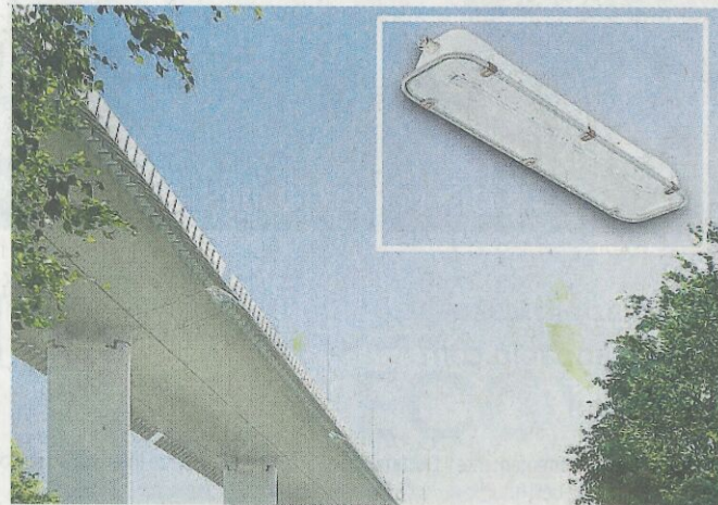
Sull'impalcato. Sono state posizionate mille plafoniere (nel riquadro)
